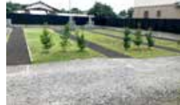
東二墓地通路舗装工事
